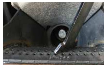
燃焼ポット表面の清掃 スクレーパーによるクリンカの除去
