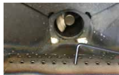
燃焼ポット給気口の清掃
